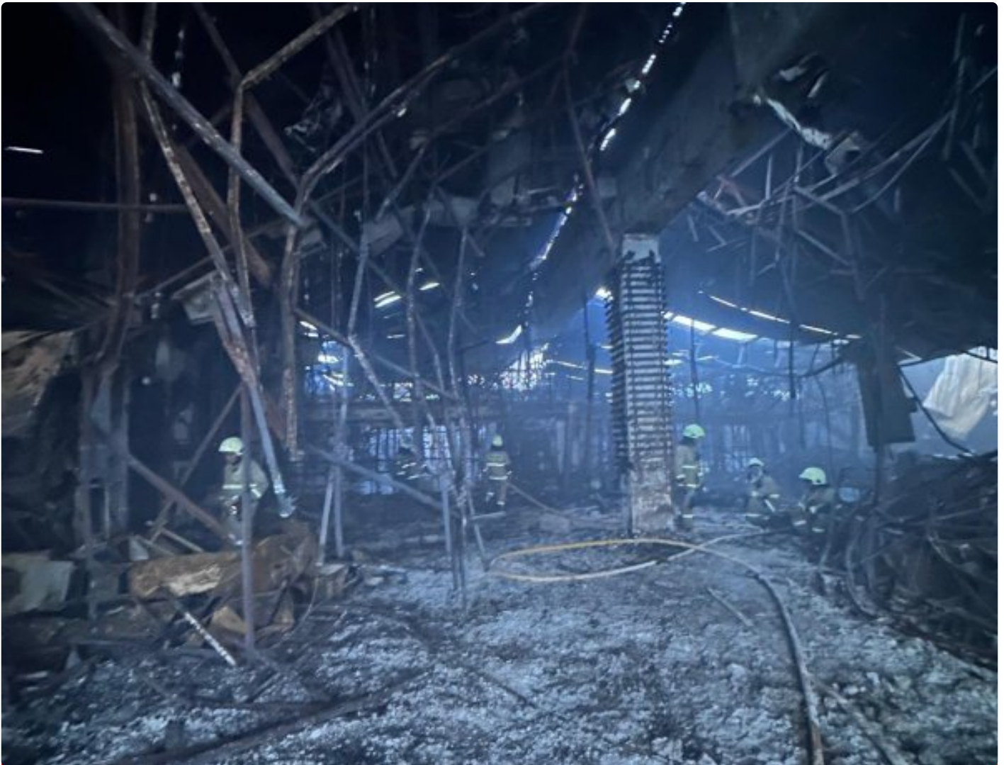
Glodok Plaza yang Hangus Terbakar
